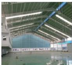
인도네시아 - 파크랜드 신축 공장 8~9 공장 보유
