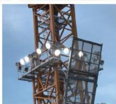
건설 공장 신축 현장
