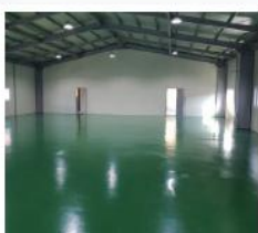
매화 신단 신축 공장
