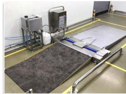
화장품 회사 설치
