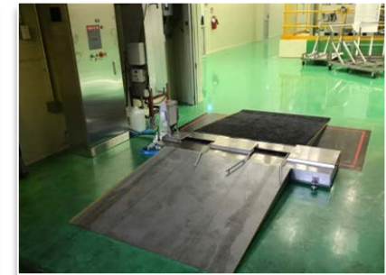
플라스틱 회사 설치
