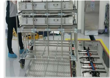
반도체 업체 설치 (삼성SDI-베트남)
