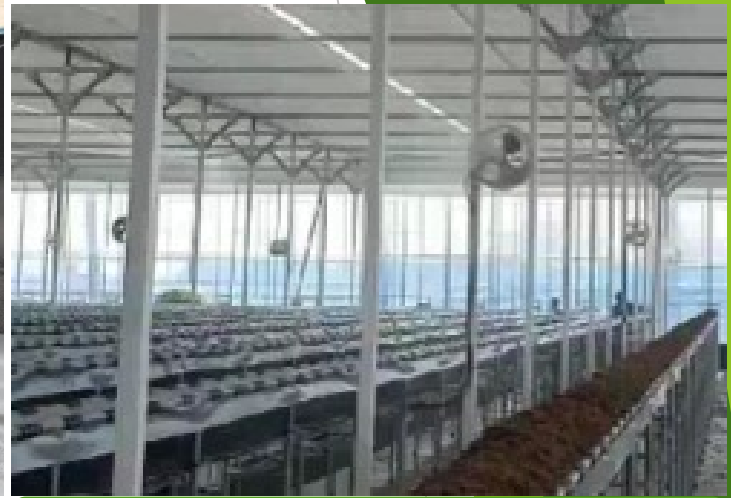
딸기 상단 부 설치
